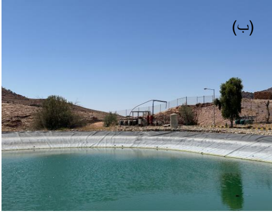
الشكل 8. (أ) حوض التهوية، (ب) بركة تجميع مياه المخرج بفترة مكوث 10 أيام، (ج) عينة مخرج مقابل عينة مدخل، (د) أحواض تجفيف الحمأة
