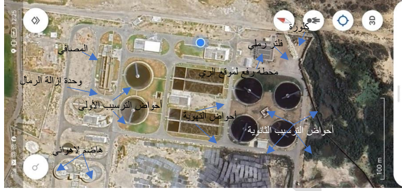
الشكل 20. وحدات محطة سوسة حمدون لتتقية المياه العادمة
