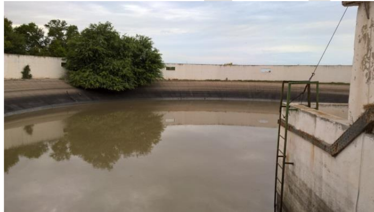
الشكل 24. الخزان التجميعي في منطقة الزاوية والذي يزود المنطقة السقوية بالمياه المستصلحة
